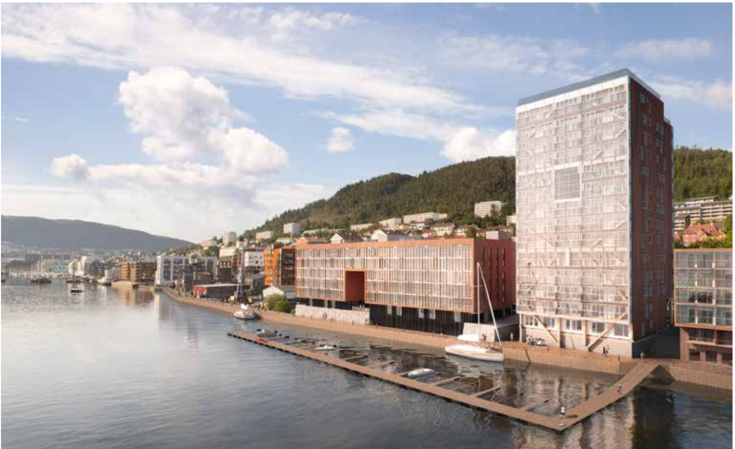
Woongebouw Treet in Bergen is ontworpen door Artec Arkitekter. In deze houthoogbouw van 51 meter hoog zijn 62 appartementen over veertien verdiepingen ondergebracht Beeld Bob BBL Bergen
